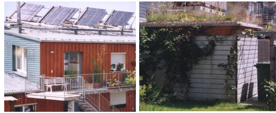
Panneaux photovoltaïques, toitures végétalisées ...
