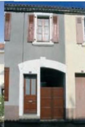
porte charretière témoignant de l'usage ancien des lieux.
