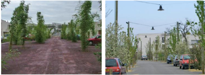
Stationnement intégré à la rue (végétalisation, continuité des liaisons piétonnes ...)
